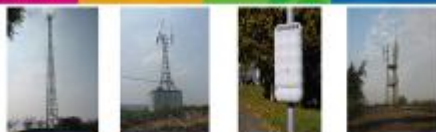
铁塔+铁塔 自建房+升空架 杆杆基站 三角杆基站
