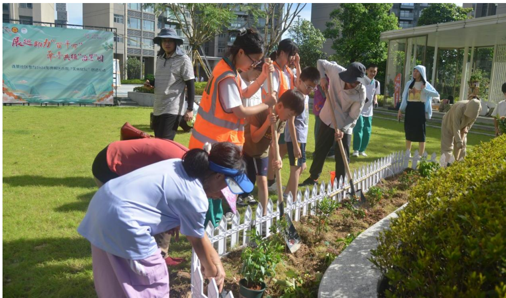
图 3.2.2 技术服务团队在泮景社区进行“美丽庭院+儿童友好”项目施工
